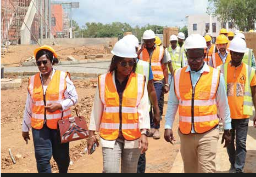
Le comité sur le chantier de construction
